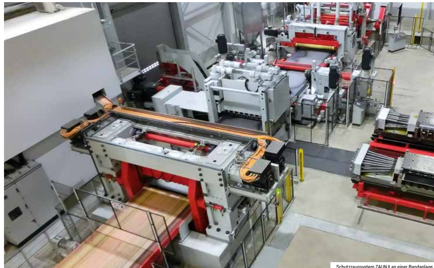
Schutzzaunsystem ZAUN II an einer Bandanlage
