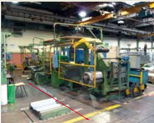
Abb. A: Maschine vor dem Umbau der Schutzeinrichtung
